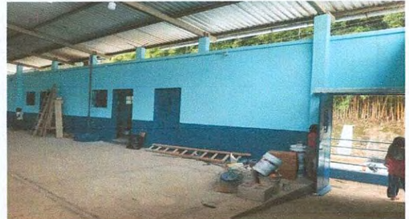
Foto 12: Remodelación salón escolar
