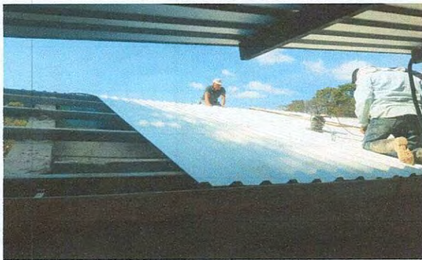
Foto 9: Cambio de techo dañado
