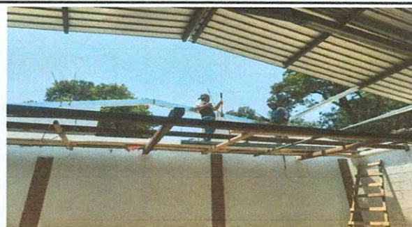
Foto 6: Cambio de techo de salón escolar.
