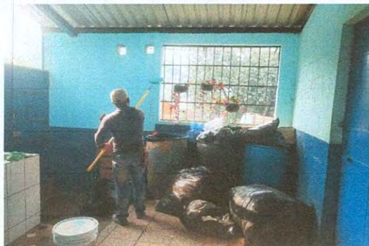
Foto1: Aplicación de pintura interiores
