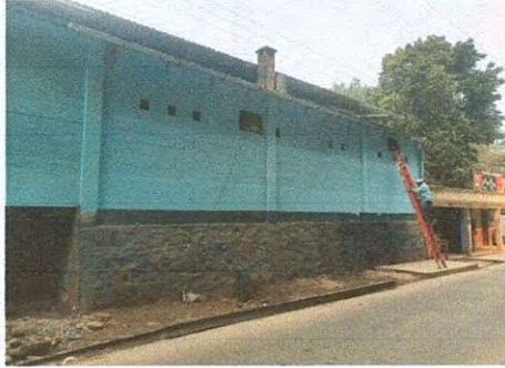
Foto 7: Aplicación de pintura exterior
